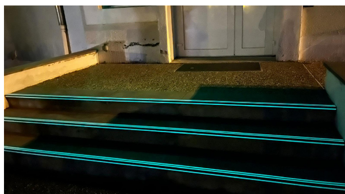
Escalier devant de la Mairie de Creuzier-le Neuf (03) Crédit Photo : Moonlight France
